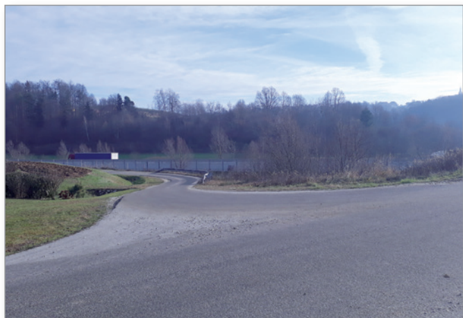
Tudi del naselja Brengova ob avtocesti dobi novi vodovod.
