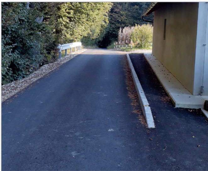
Dokončan in v uporabo predan odsek ceste
