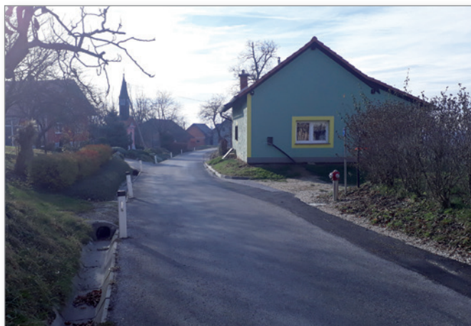
Naselje Peščeni Vrh ima obnovljen vodovod.
